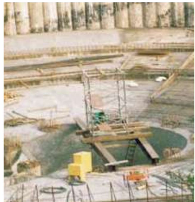
Kläranlage Bodenplatte Predimax 19. Arbeitsfugen senkrecht Quellmax.
