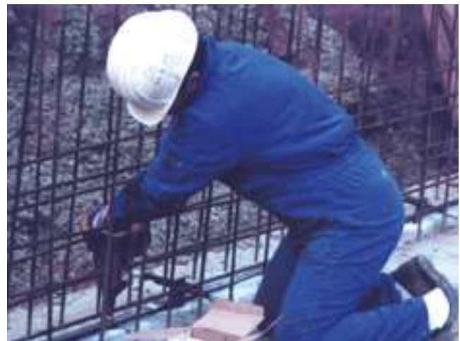
Vor dem Anschließen der Halteschiene ist darauf zu achten, daß das Quellband fugenmittigg liegt
