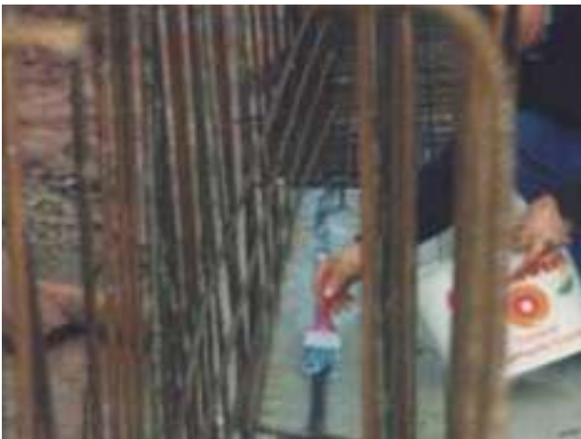
Quellband mit Resistrol RP10 einsprühen oder einpinseln. Resistrol RP10 kann auch nach dem Anschließen aufgetragen werden
