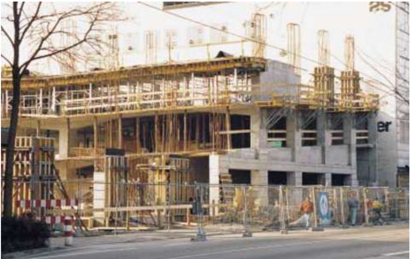
In diesem Bauwerk wurden die Boden/Wandfugen mit Predimax® -Injektionsschläuchen gesichert, die Parkdeckfugen mit Quellmax® und die Außenwände mit Sollrißfugenschienen
