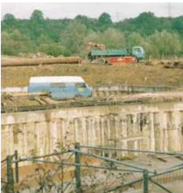
Kläranlage Bodenplatte Predimax 19. Arbeitsfugen senkrecht Quellmax.
