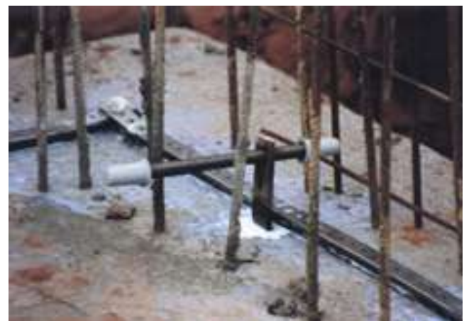
Abdichtung mit Quellmax® Boden/Wandfuge
