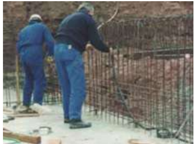
Einlegen des Quellbandes in die gereinigte Fuge
