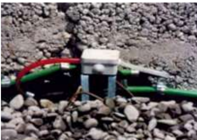
Abdichtung mit Predimax® Boden/Wandfugen
