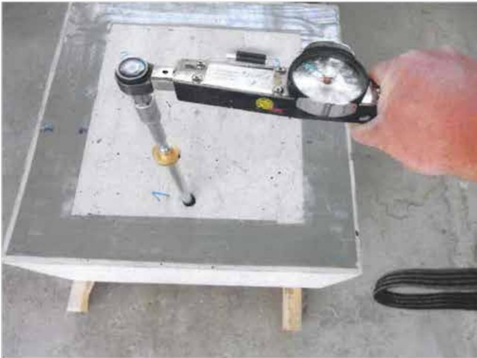
Bild 3: Einsetzen eines NIK-Dichtungseinsatzes 19x70 mm
