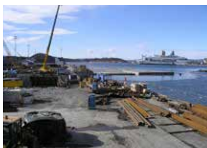
Bjørvikatunnel I, Oslo (Norwegen)
