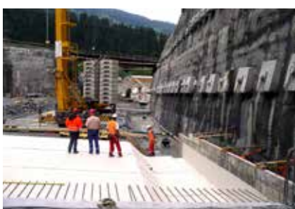
Tunnel, Küblis (Schweiz)
