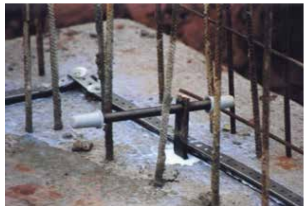
Abdichtung mit Quellmax® Boden/Wandfuge
