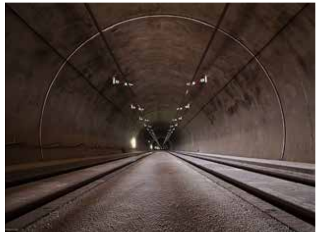
Tunnelbau / Abdichtung + Firstspaltverpressung
