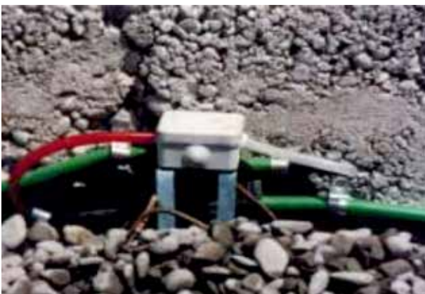
Abdichtung mit Predimax® Boden/Wandfugen
