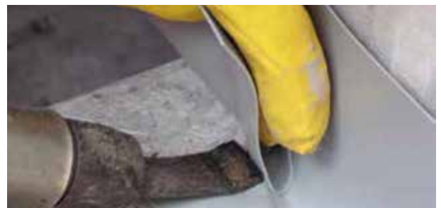
4. Verbinden der Dichtelemente durch Schweißen
