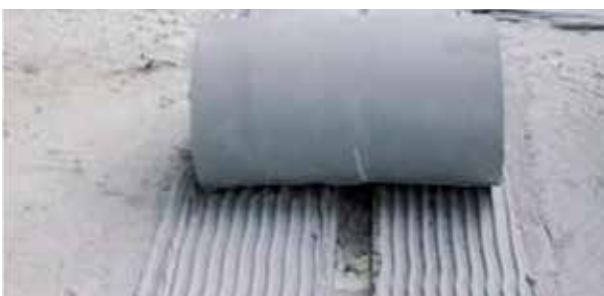
3. Einbringen des Dichtelements
