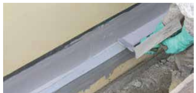
5. Aufbringen des Deckauftrages
