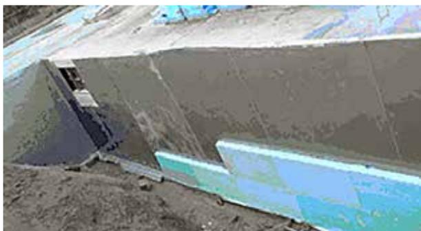
SilverSeal® muss immer so eingebaut werden, dass das Vlies zur abzudichtenden Betonkonstruktion zeigt. Die silberne Folie ist wasserseitig anzuordnen!
