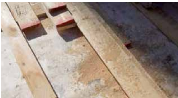
Sägemehl durch Sägearbeiten muss vor der Betonage entfernt werden
