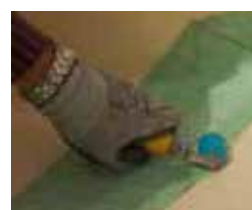
6. Überlappungsstoß ausbilden und Innentape Sika® Proof Tape-150 anbringen
