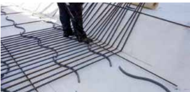
Bewehrungsarbeiten auf einer Sika® Proof A
