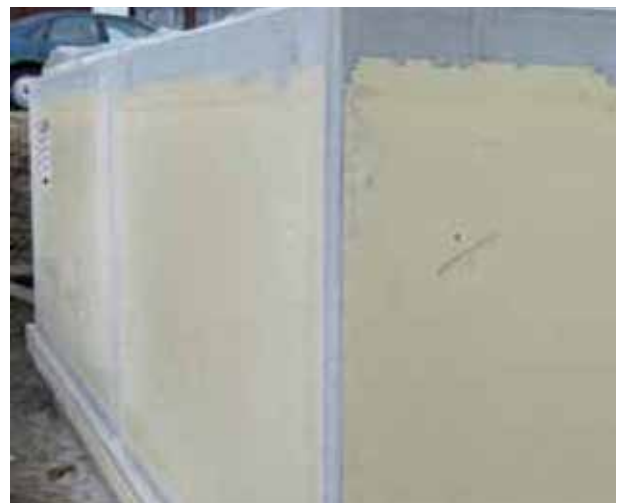
Fertigteilwände mit Sika® Proof A in der Fläche, die Stoßfugen werden mit dem Tricoflex®-Abklebesystem abgedichtet
