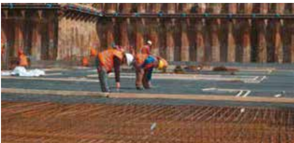
Bewehrungsarbeiten auf einer Sika® Proof A
