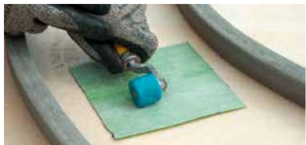
Reparatur einer Beschädigung mit Sika® Proof Tape-150
