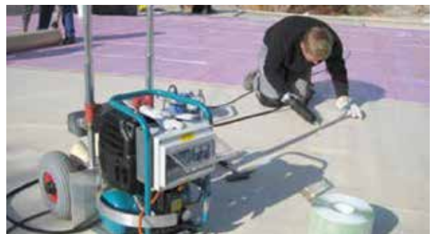
Querstoß mit anschließender Verklebung mittels Heißkleber
