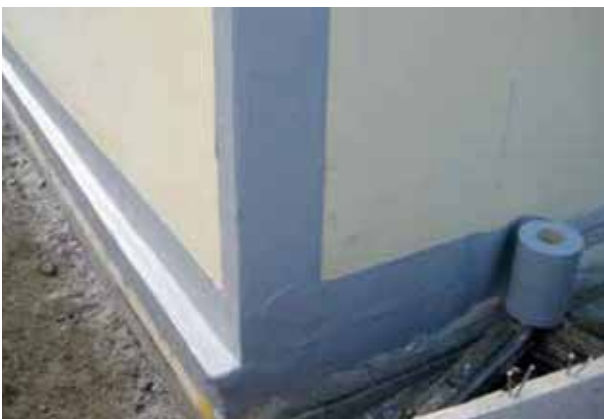
Kombination von Sika® Proof A und Tricoflex®
