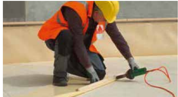
Thermisches Umformen der Bahn mit einem Heißluftföhn
