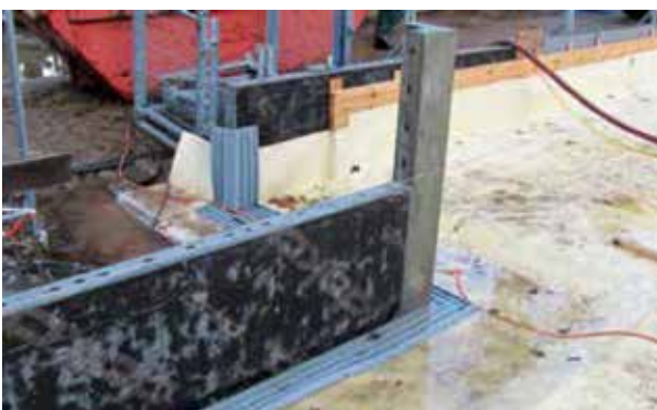
Ausbildung einer Dehnfuge mit Tricoflex® Profil DFT 330/3
