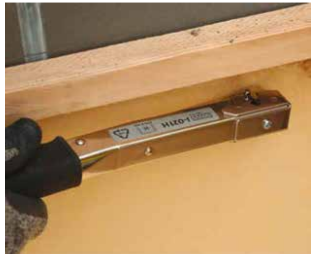
Befestigung der Membran mit Schlagtacker im obersten Randbereich
