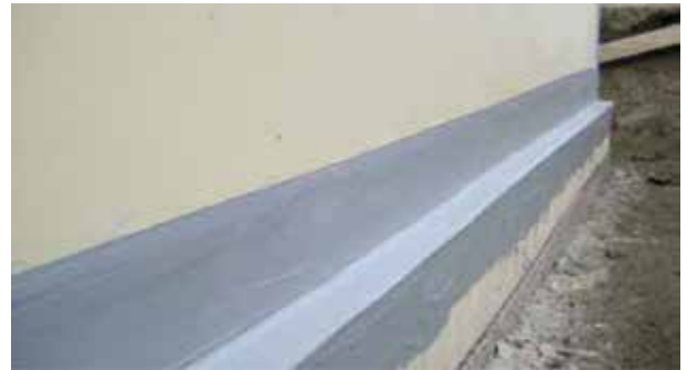
Beispiel einer Boden-Wand-Fuge mit Ausbildung eines Bodenüberstandes
