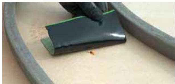
Reparatur einer Beschädigung mit Sika® Proof Tape-150
