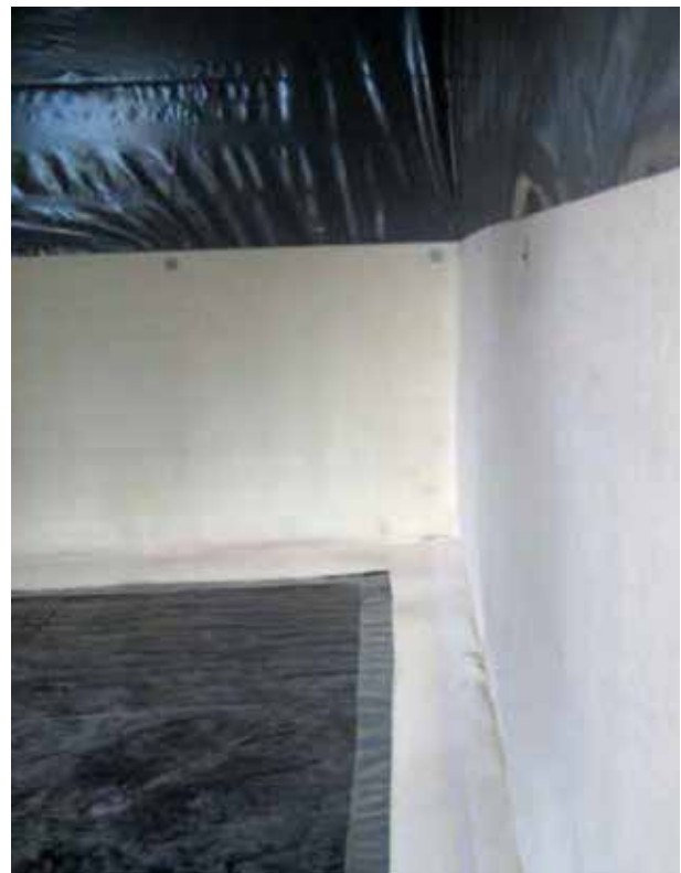
Befestigung am Beispiel von Tellerkopfnägeln in einhäufigen Bereichen
