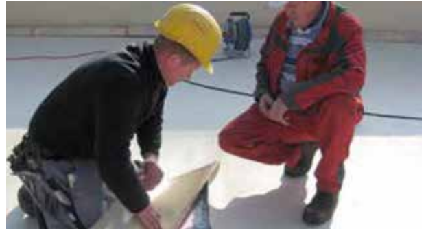
Ausbildung eines Querstoßes mit Innen- und Außentape
