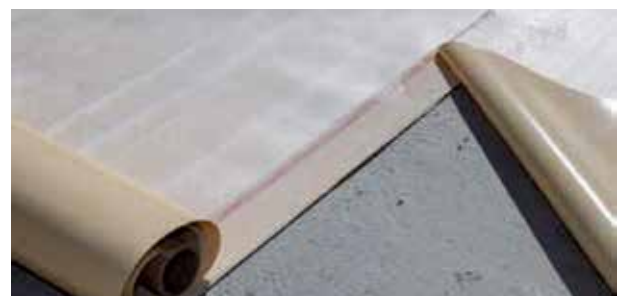
Längsstoß mit Selbstklebestreifen und Verlegemarkierung
