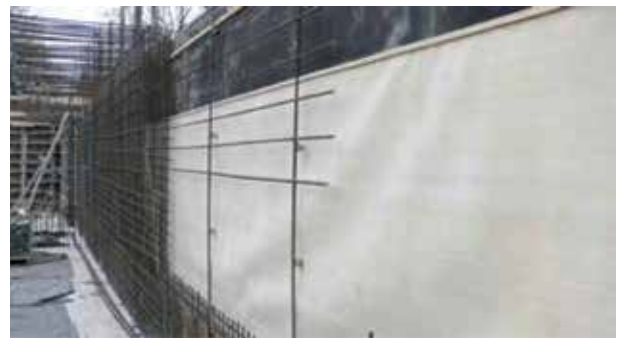
Mit Sika® Proof A vorbereitete Schalung
