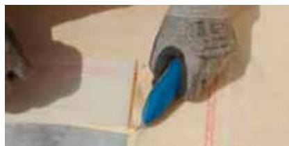
5. Freien Rand zurückschneiden, zur Vermeidung einer Kapillare
