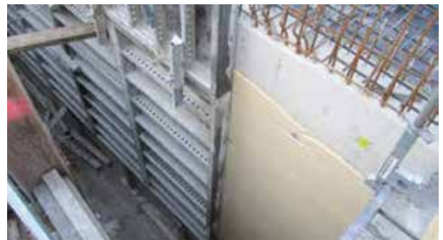
Zweihäufig geschaltete Wandkonstruktionen – Außenseite der Sika® Proof A nach dem Ausschalen
