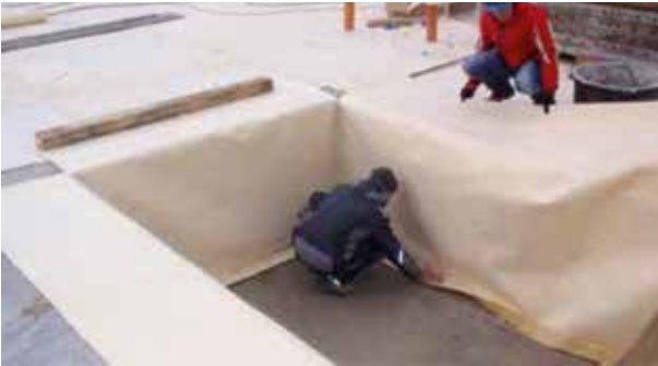
Ausbildung von Spiegelecken bei Höhenversprüngen
