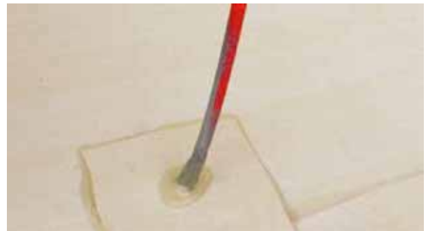
Eindichtung eines Fundamenterde mit Heißkleber
