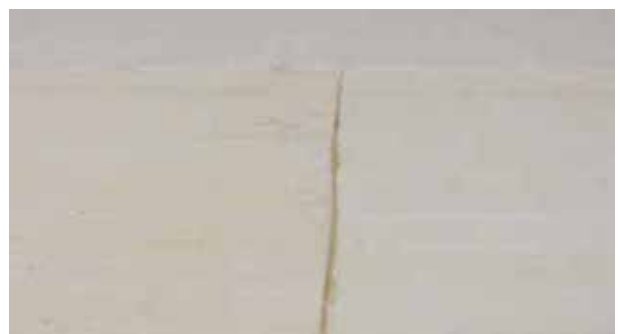
Querstoß mit anschließender Verklebung mittels Heißkleber
