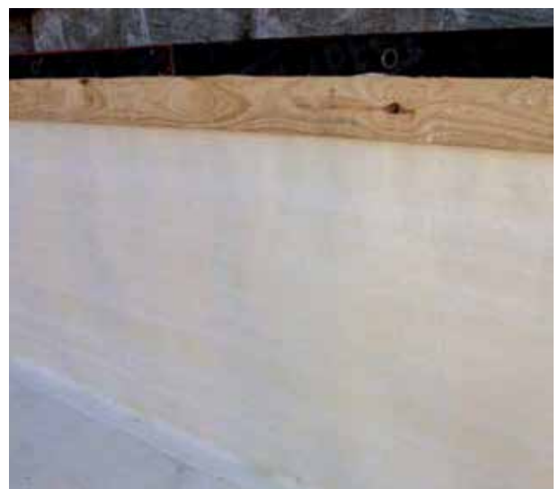
Befestigung mit einer Nagelleiste im oberen Randbereich
