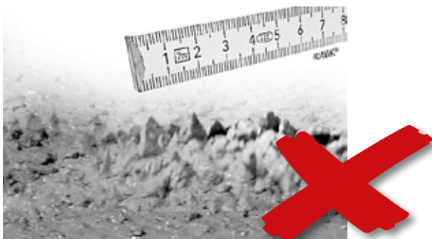
Scharfe Steine oder Kanten entfernen
