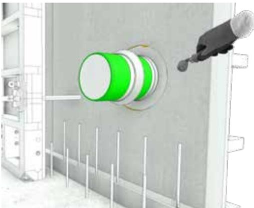
Verklebung mit Innentape HotMelt oder thermisch fügen, bei thermischer Fügung Vlies im Fügebereich entfernen
