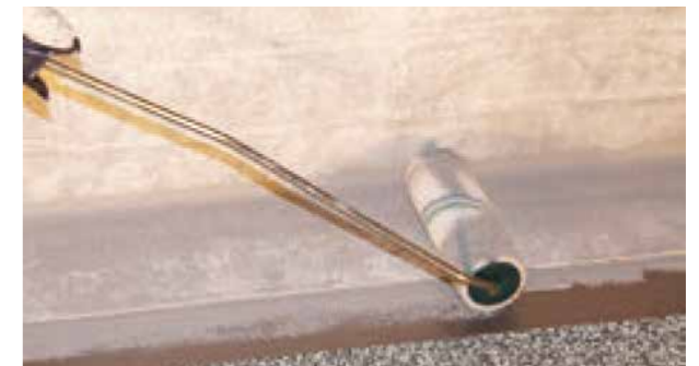
In die noch frische Abdichtung der 1. Lage wird das Polyestervlies falten- und hohlraumfrei eingerollt. Die Polyestervliese müssen mindestens 5 cm überlappen..
