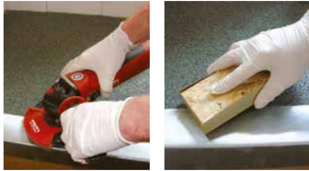
1. Schleifen Sie die Oberfläche mit einer Flex oder einem Schleifkloben an, um eine Gripverbesserung durch Oberflächenvergrößerung zu erzeugen
