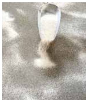
5. Abgesandete BT-Grundierung bei genutzten Flächen
