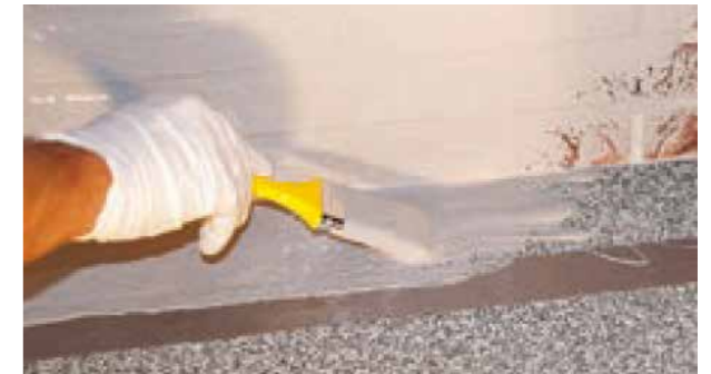
Verteilen Sie NIK® Seal 1K auf eine gleichmäßige Schichtstärke. Mindestens die Hälfte der geplanten Menge der Abdichtung (1/2 bis 2/3) wird in der 1. Lage aufgebracht.
