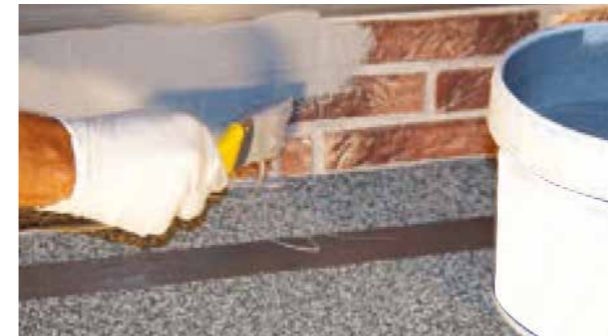
Verteilen Sie NIK® Seal 1K auf eine gleichmäßige Schichtstärke. Mindestens die Hälfte der geplanten Menge der Abdichtung (1/2 bis 2/3) wird in der 1. Lage aufgebracht.
