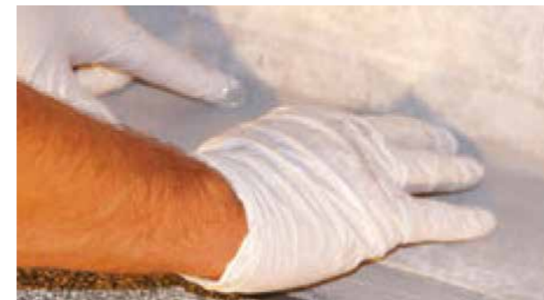
In die noch frische Abdichtung der 1. Lage wird das Polyestervlies falten- und hohlraumfrei eingerollt. Die Polyestervliese müssen mindestens 5 cm überlappen..
