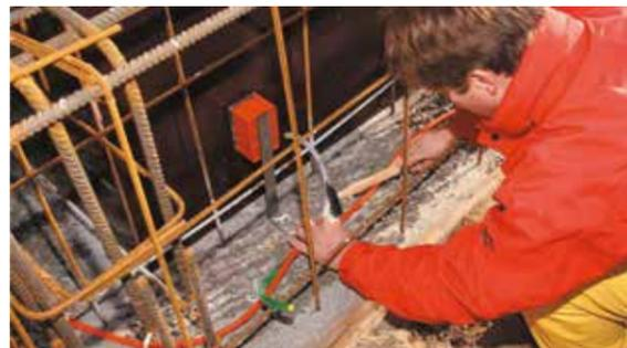
Die Injektionstechnologie bildet heute einen wesentlichen Baustein der Betoninstandsetzung und gewinnt zunehmend an Bedeutung. Die Anwendungsfälle reichen vom gerissenen Stahlbeton, infolge Krafteinwirkung zur wasserundichten Oberfläche bis hin zu Hohlräumen aufgrund mangelhafter Bauausführung der Vorgewerke.
