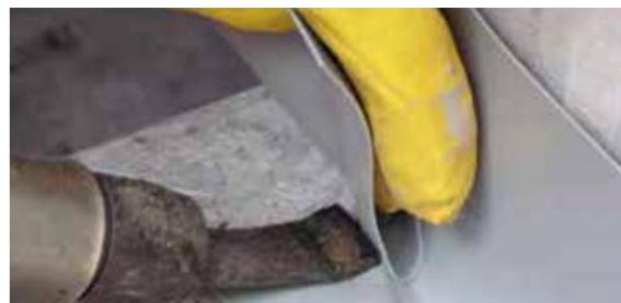
4 Verbinden der Dichtelemente durch Schweißen
