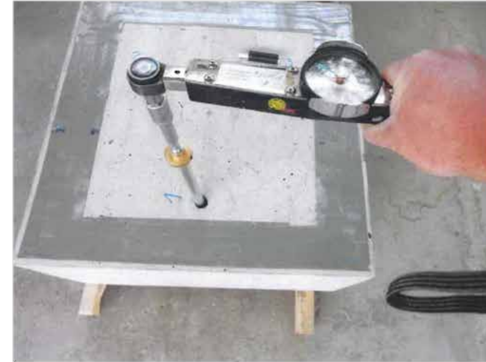
Bild 3: Einsetzen eines NIK-Dichtungseinsatzes 19x70 mm
