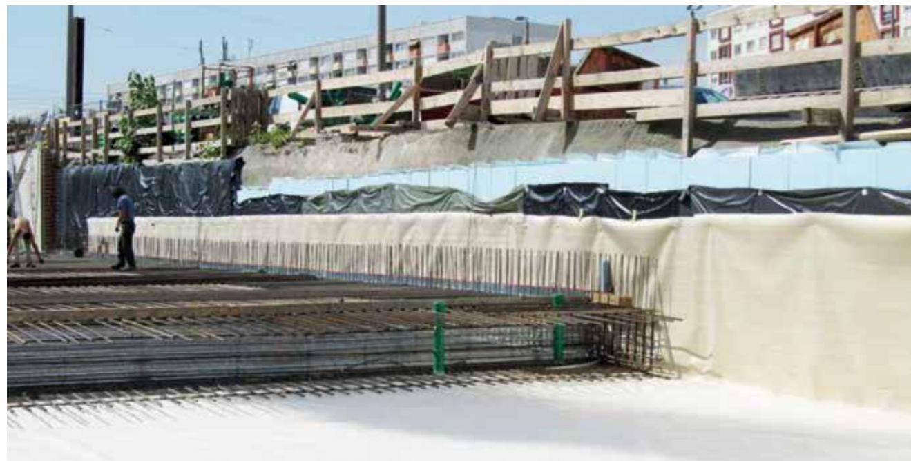
Beispiel einer Boden-Wand-Fuge ohne Ausbildung eines Bodenüberstandes, in diesem Fall mit einer Tricoflex® Abklebung
