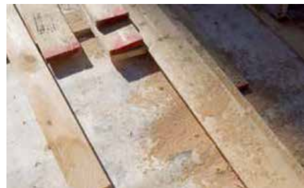
Sägemehl durch Sägearbeiten muss vor der Betonage entfernt werden
