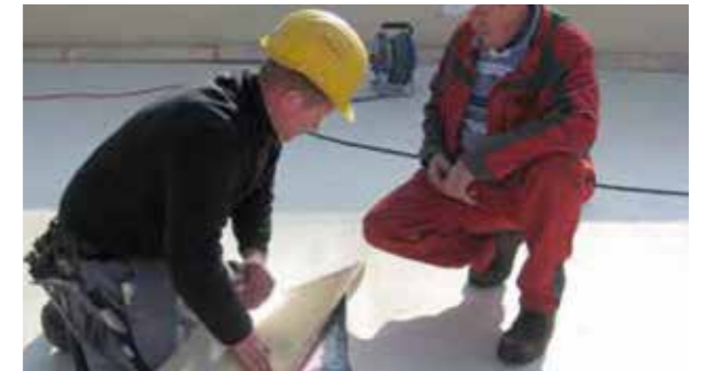
Ausbildung eines Querstoßes mit Innen- und Außentape
