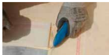
5 Freien Rand zurückschneiden, zur Vermeidung einer Kapillare
