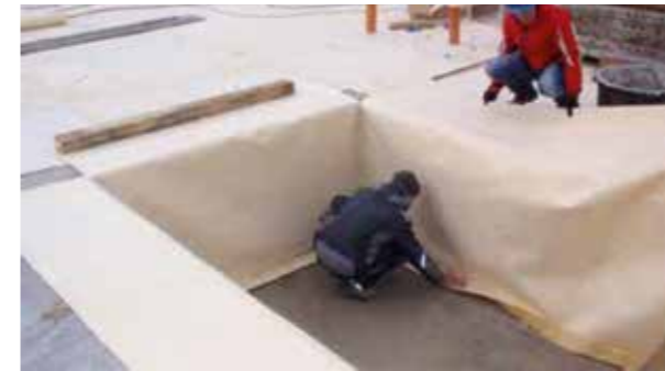
Ausbildung von Spiegelecken bei Höhenversprüngen
