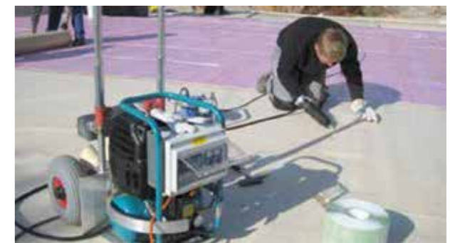
Querstoß mit anschließender Verklebung mittels Heißkleber
