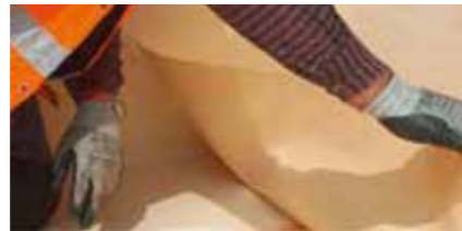
3 Fixieren mit Selbstklebestreifen und schräg schneiden der Überlappung
