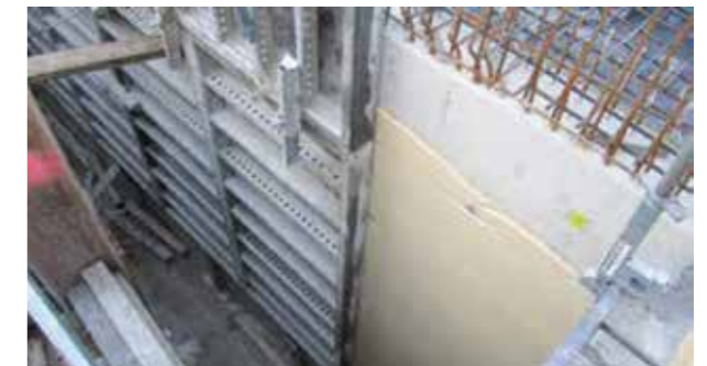
Zweihäufig geschaltete Wandkonstruktionen – Außenseite der SIKAR®Proof A nach dem Ausschalen
