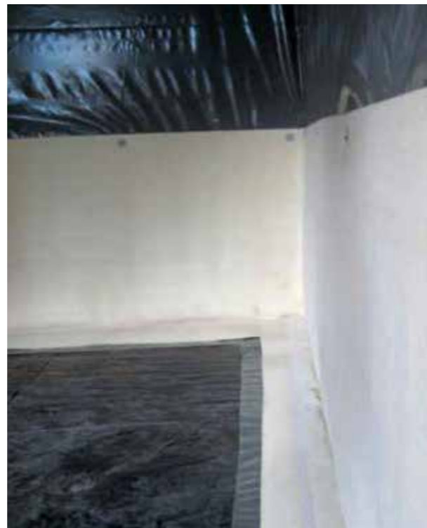
Befestigung am Beispiel von Tellerkopfnägeln in einhäufigen Bereichen
