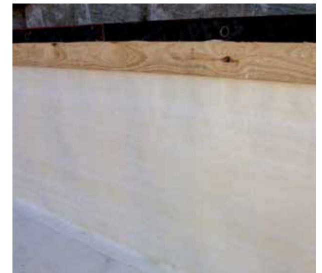
Befestigung mit einer Nagelleiste im oberen Randbereich
