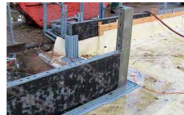
Ausbildung einer Dehnfuge mit Tricoflex® Profil DFT 330/3
