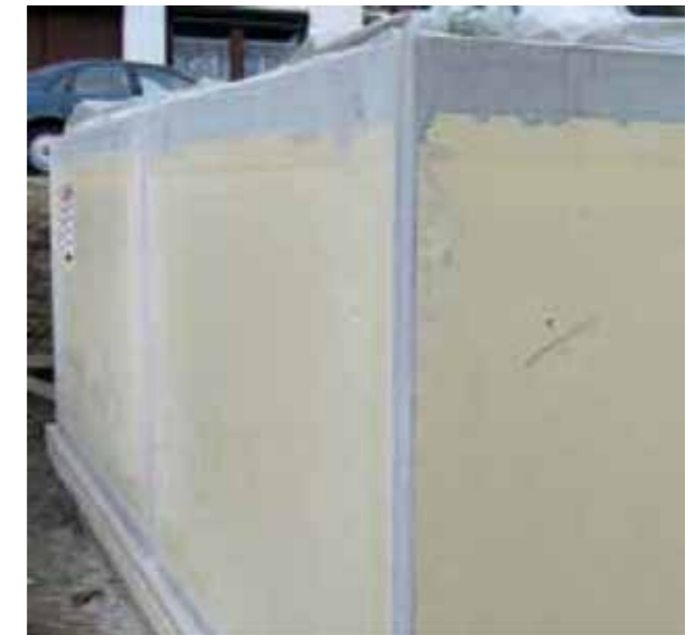
Fertigteilkeller mit SIKA®Proof A in der Fläche, die Stoßfugen werden mit dem Tricoflex®-Abklebesystem abgedichtet
