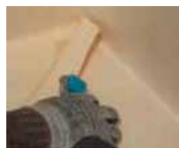
6 Überlappungsstoß ausbilden und Innentape SIKA®Proof Tape-150 anbringen
