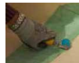
6 Überlappungsstoß ausbilden und Innentape SIKA®Proof Tape-150 anbringen
