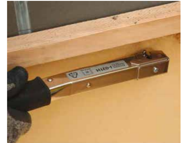
Befestigung der Membran mit Schlagtacker im obersten Randbereich
