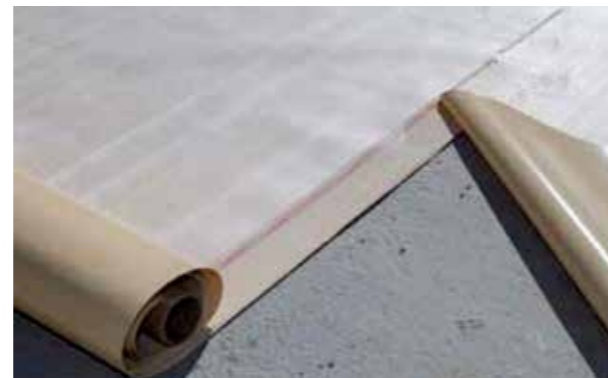
Längsstoß mit Selbstklebestreifen und Verlegemarkierung
