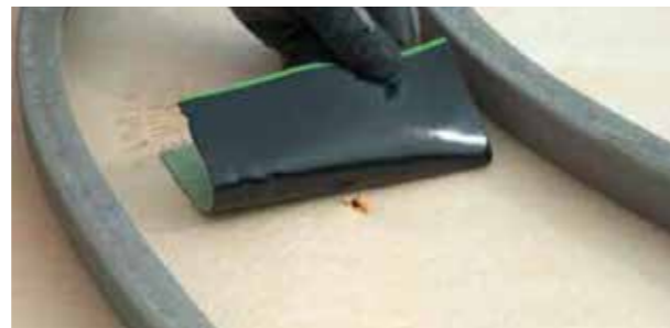
Reparatur einer Beschädigung mit SIKAProof Tape-150
