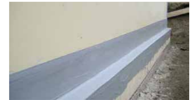
Beispiel einer Boden-Wand-Fuge mit Ausbildung eines Bodenüberstandes
