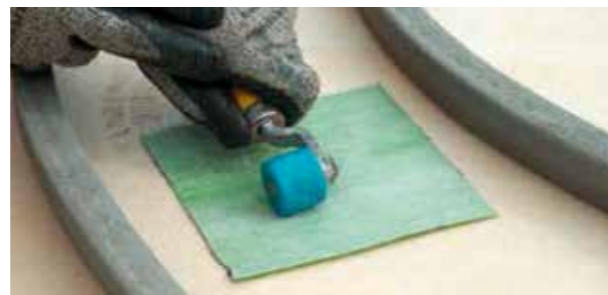
Reparatur einer Beschädigung mit SIKAProof Tape-150
