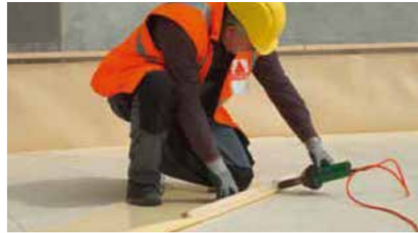
Thermisches Umformen der Bahn mit einem Heißluftföhn
