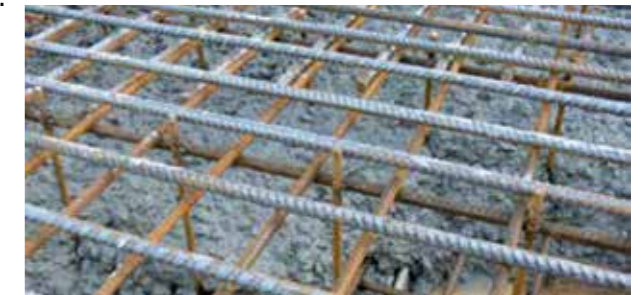
Betonarbeiten auf einer SIKAProof A
