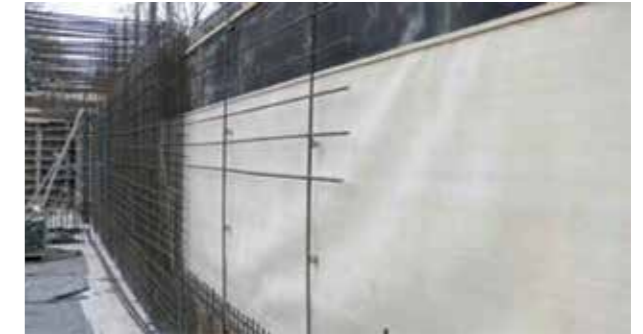
Mit SIKAR®Proof A vorbereitete Schalung
