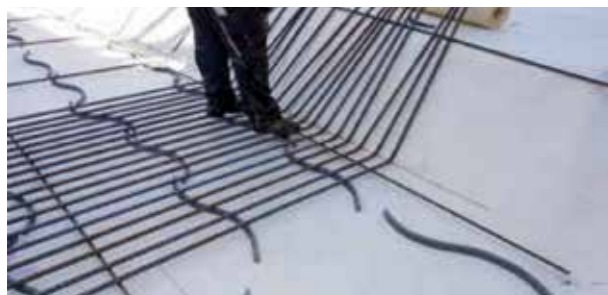
Bewehrungsarbeiten auf einer SIKAProof A
