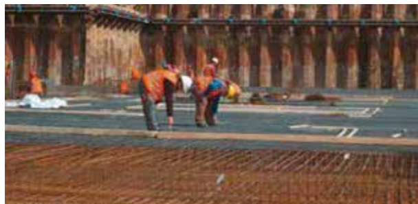
Bewehrungsarbeiten auf einer SIKAProof A
